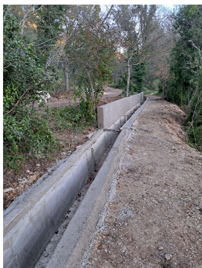
Travaux de mise en aérien du Béal à Versainte
